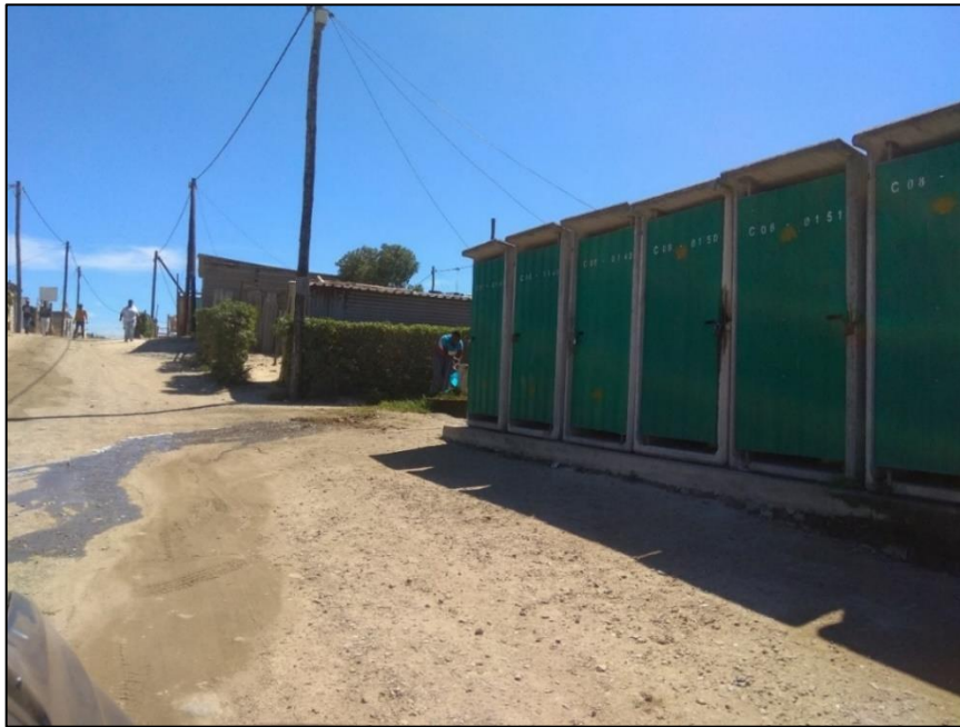
Figure 4:21: Communal pour flush toilets.
